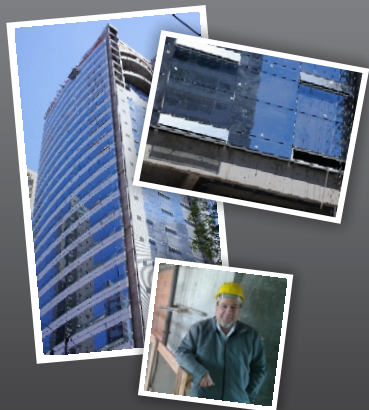
Edifício Acaraí, Brooklin, São Paulo-SP 18 mil m2 de Fachada Unitizada
