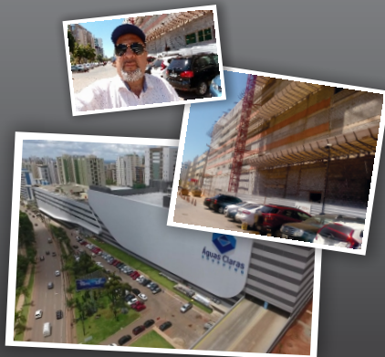
Águas Claras Shopping, Águas Claras-DF 23 mil m2 de Revestimento ACM
